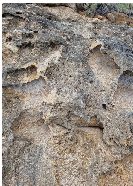
Erosion en niche
